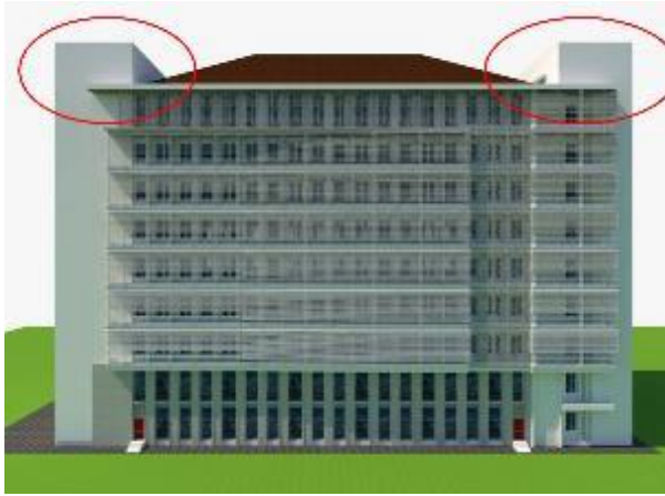
Gambar 7 Vertical Irregularity pada gedung RIC
