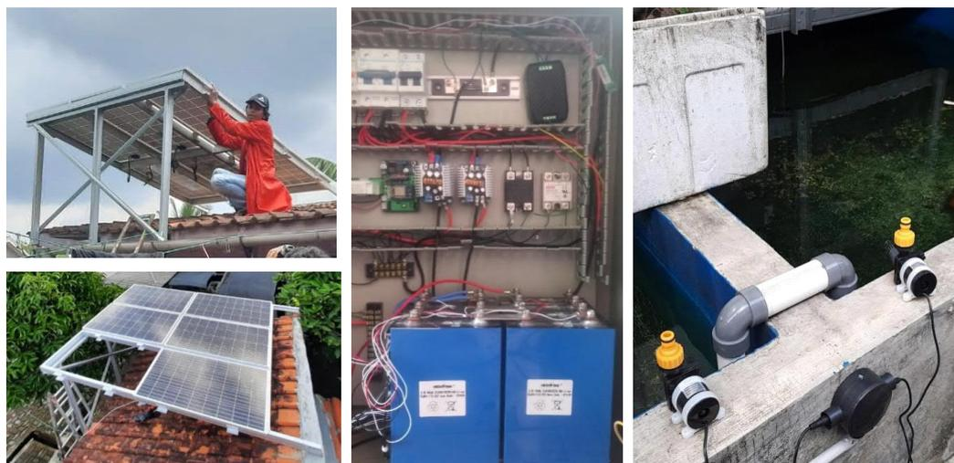
Gambar 2. Instalasi solar panel, pompa, dan panel baterai
