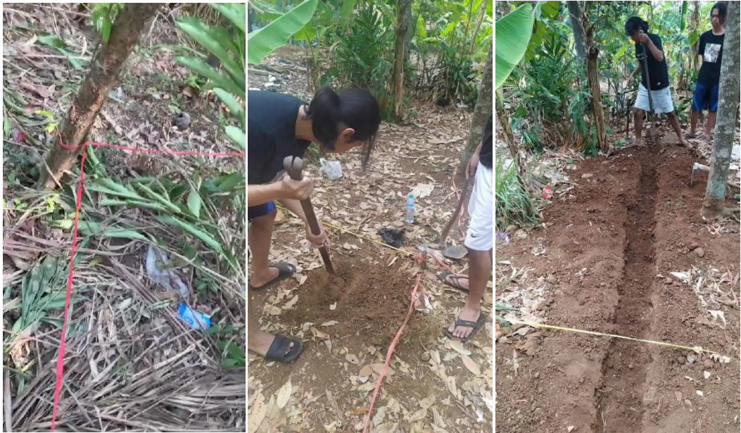
Gambar 10. Penandaan dan penggalian tanah untuk pemasangan pipa-pipa di Dusun Bina Loka
