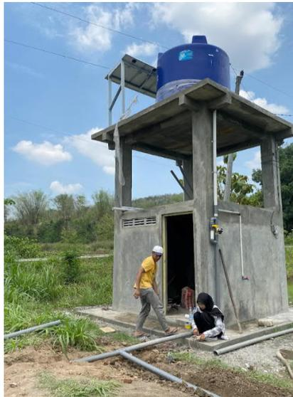
Gambar 1. Pembangunan bak penampungan air dan perpipaan
