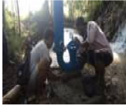
Gambar 10. Pemasangan pompa hidram
