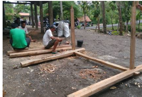
Gambar 8. Proses pembangunan gazebo
