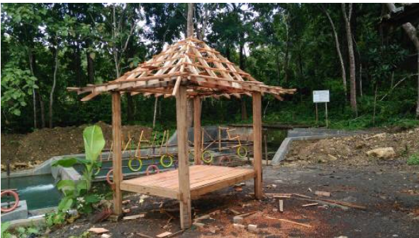
Gambar 9. Gazebo sebelum finishing
