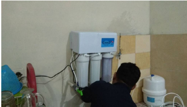
Gambar 6. Proses Pemasangan Alat Reverse Osmosis (RO)
