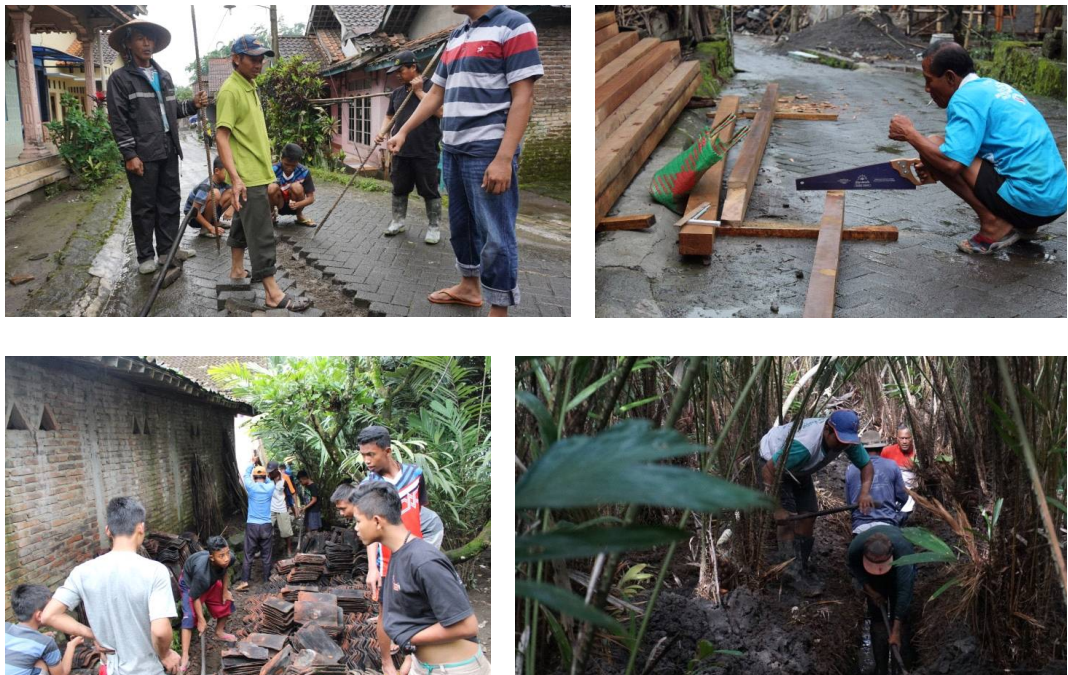
Gambar 5. Proses Perbaikan dan Pemasangan Saluran Pipa Air
