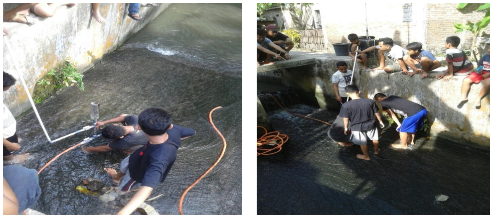
Gambar 8. Uji Coba Pompa Air
