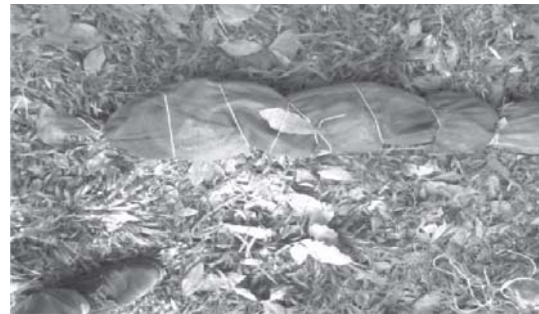
Gambar 5. Desain sabut kelapa untuk drainase bawah tanah
