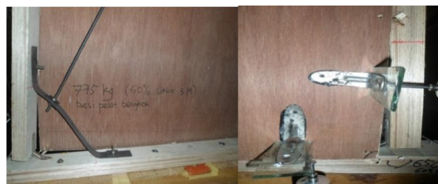
(e) Buckling Pada Corner Plate (d) Pull-Through Sheathing Failures
