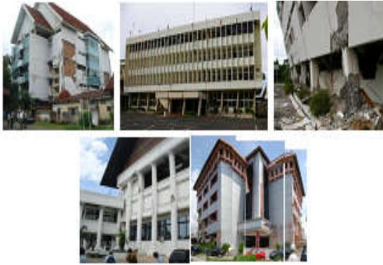
GAMBAR 4. Kerusakan bangunan akibat gempa tahun 2009
