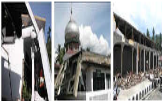
GAMBAR 3. Kerusakan bangunan akibat gempa tahun 2007
