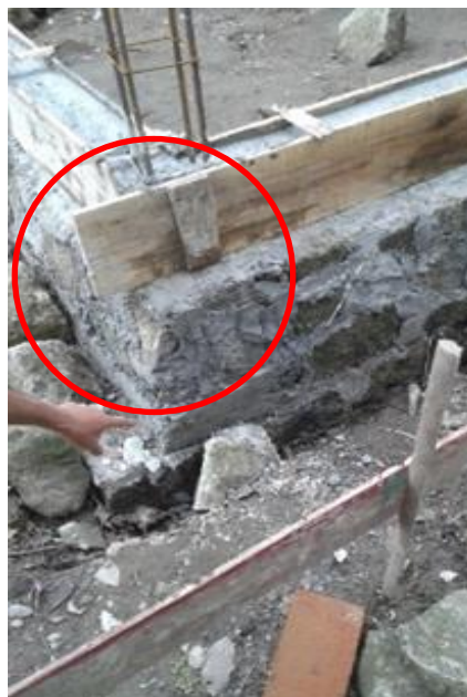
GAMBAR 1. Penggunaan angkur kolom pada pondasi batu kali
