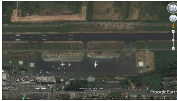
GAMBAR 7. Lokasi penambahan taxiway pada Bandar Udara Radin Inten II
